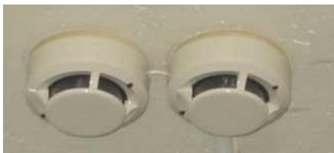
Рис. 7. Расстановка извещателей для двойного контроля помещения
